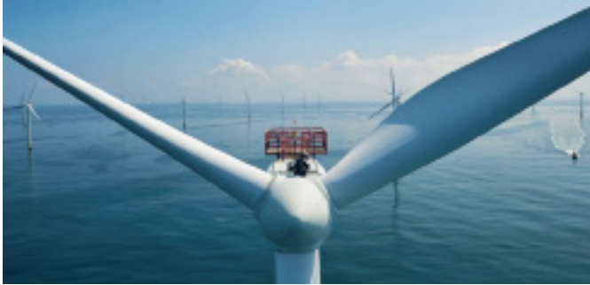
Typical Vattenfall wind turbines
